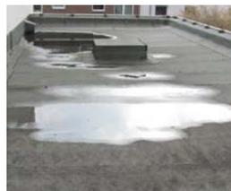
Bei **großflächiger Pfützenbildung** steigt das Schadensrisiko und sinkt die Alterungsbeständigkeit der Abdichtung. Haftreibewerte werden vermindert.
